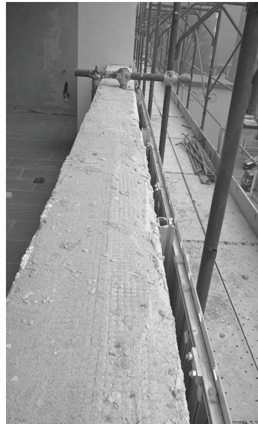
Fissaggio della facciata ventilata su muratura in AAC
