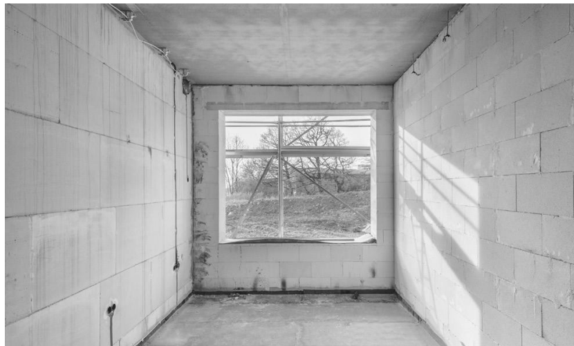
Connessione tra muri perimetrali e tramezze interne
