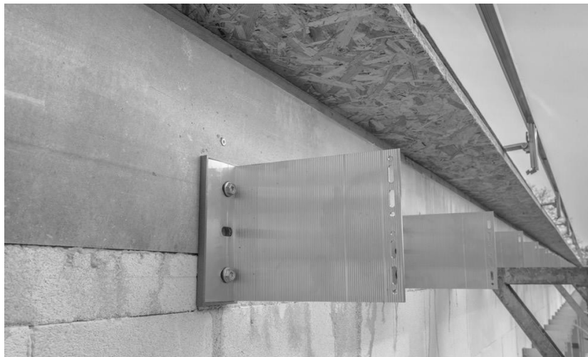
Fissaggio della facciata ventilata ai blocchi in AAC
