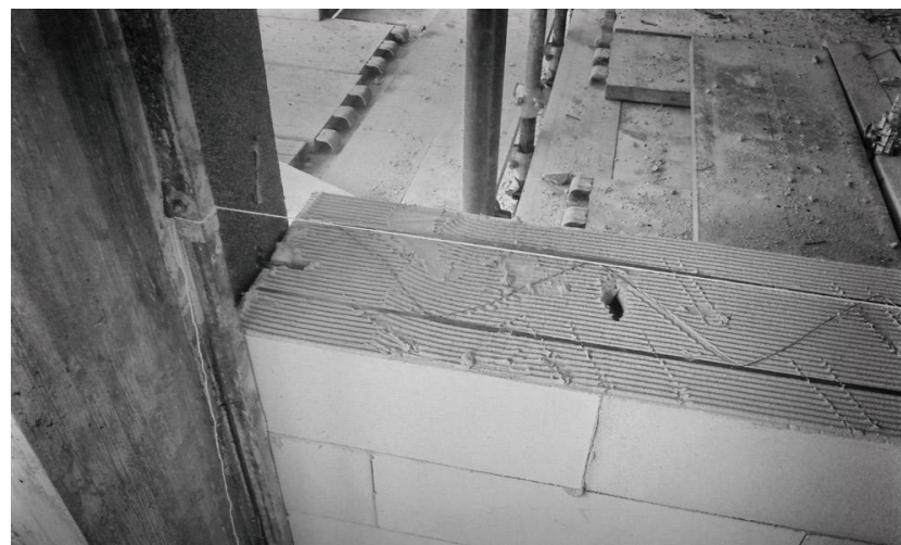
Rinforzo della muratura in tralici di acciaio inseriti nei corsi di malta
