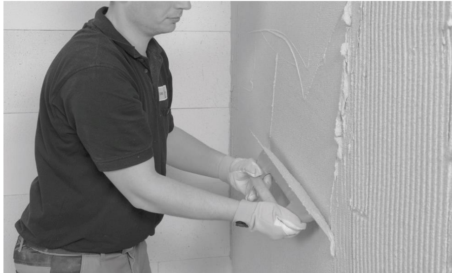
Esecuzione della rasatura armata
