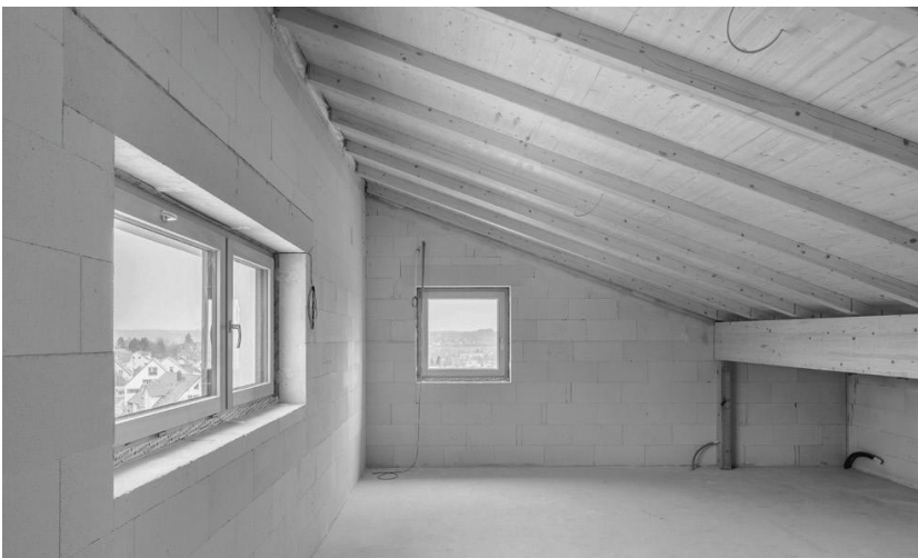
Ancoraggio copertura in legno lamellare su muratura
