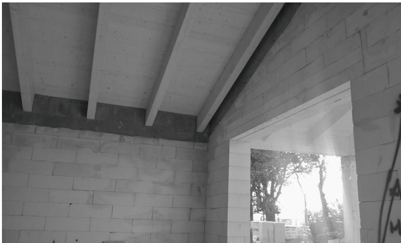
Ancoraggio copertura in legno lamellare su muratura
