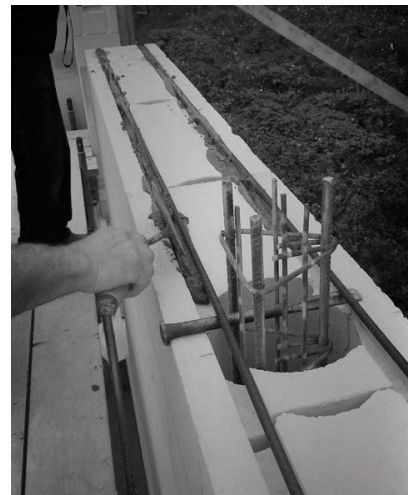
Utilizzo di blocchi forati per la realizzazione di elementi di irrigidimento in c.a.
