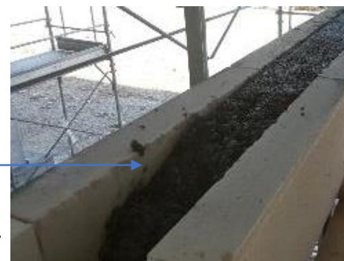
BLOCCO CANALETTA A «U» per irrigidimenti verticali
