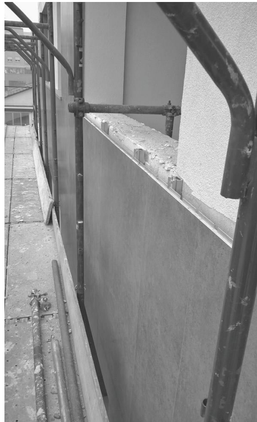
Fissaggio della facciata ventilata su muratura in AAC
