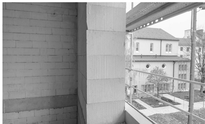
Particolare apertura su muratura di tamponamento
